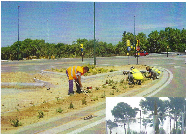
Un equipo de Consolida Oliver trabaja en las obras de remodelación de la rotonda de la Cooperativa del Taxi, dentro de las concedidas por el Plan E. en Zaragoza.
